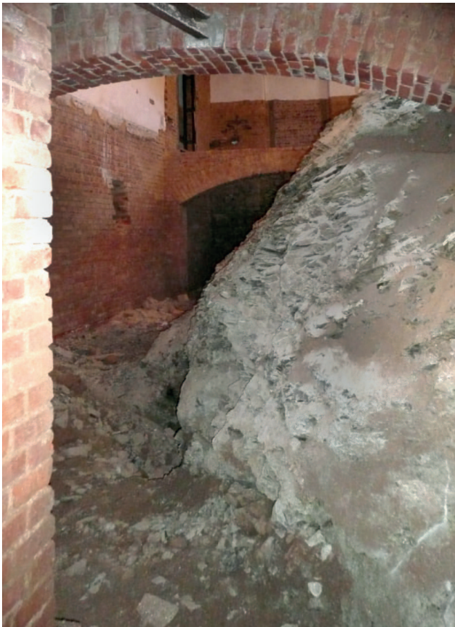
Gründungsbereich im Untergeschoss mit anstehendem Fels
