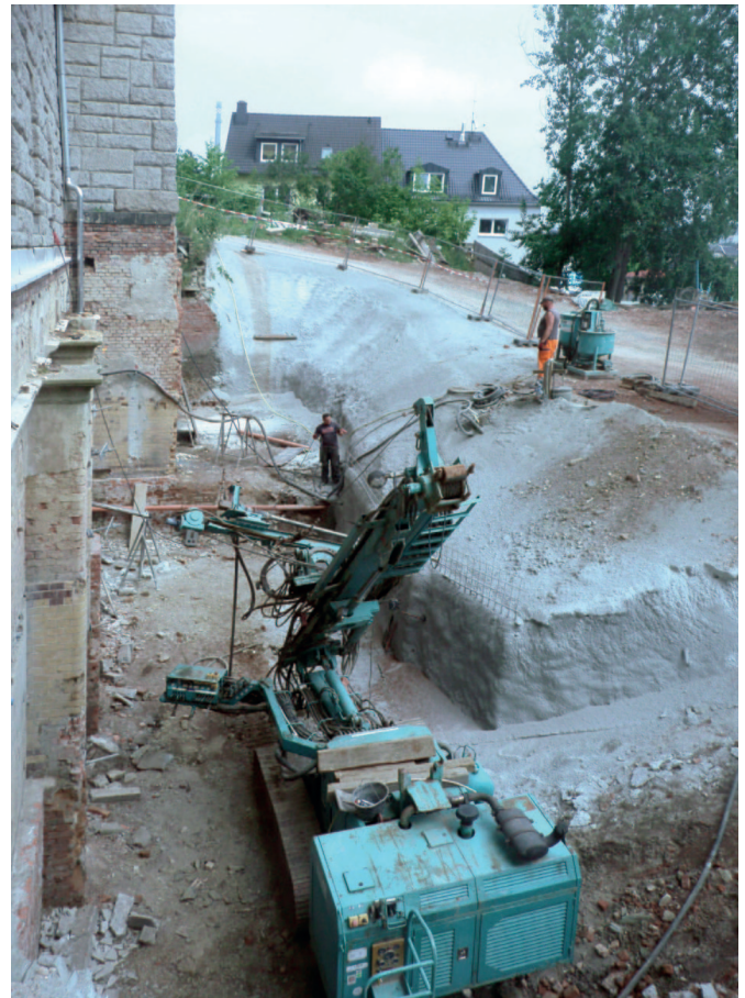
Herstellen der horizontalen Entlastungsbohrungen zur Drainierung des Felsens unter dem Gebäude
