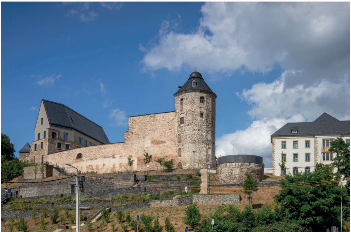
Blick von der Syrastraße auf die Stadtkrone
